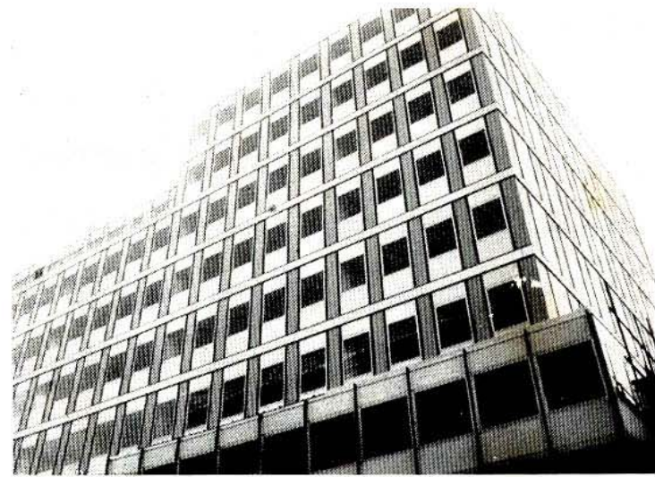
Le facciate in via di costruzione.
